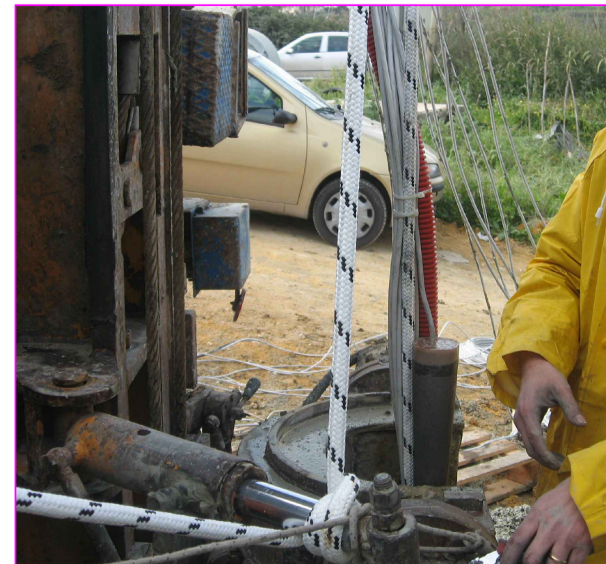
Foto fissaggio e posa Anodi
